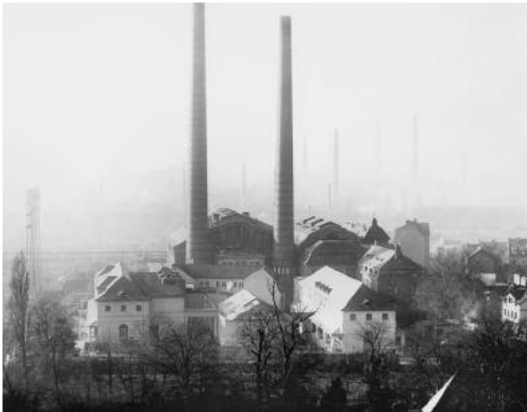
Blick von Osten über das Kraftwerk der MKW, um 1925.
